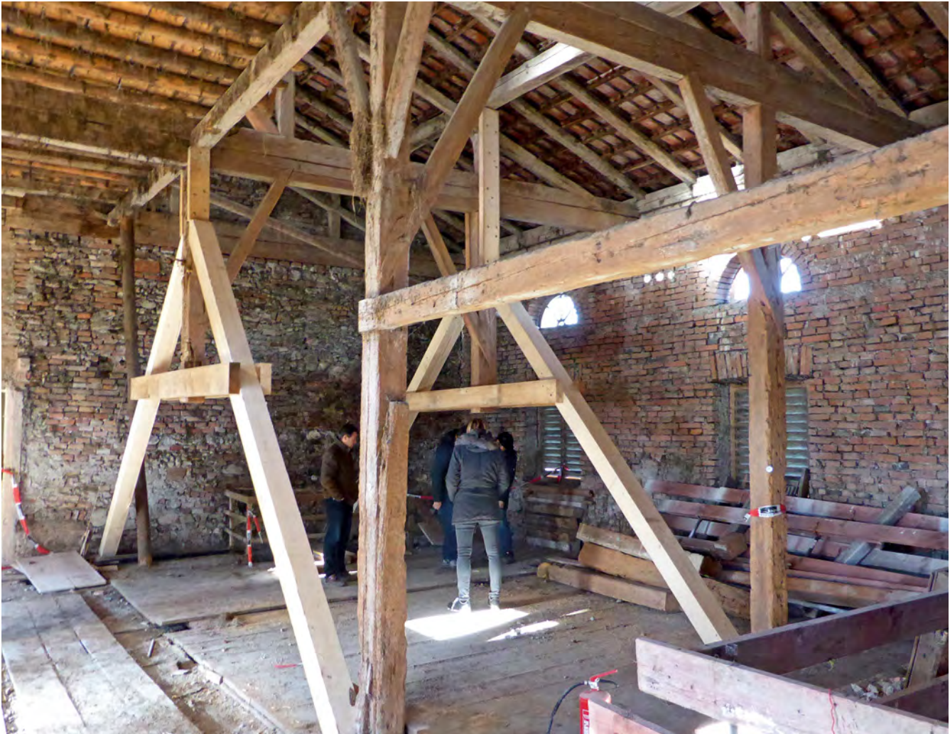
Erste Arbeiten zur Ertüchtigung der Holzteile im Tennenbereich
