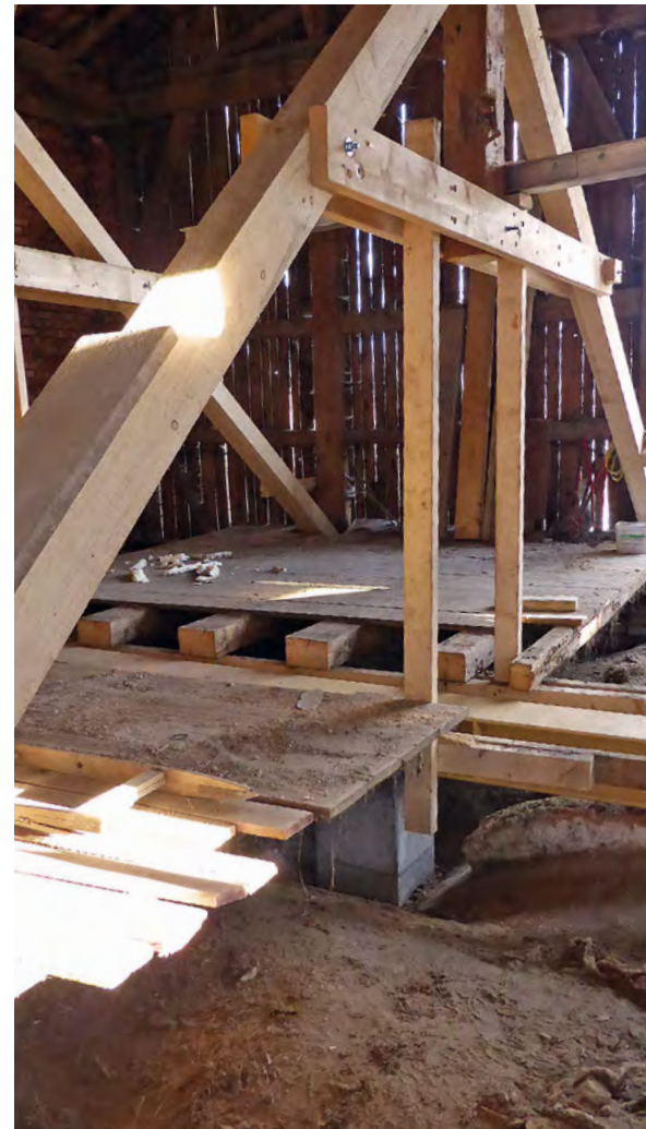
Alte und neue Teile werden zusammengefügt
