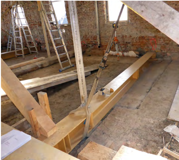
Zur Sicherung der Decken wurden Stahlträger eingezogen
