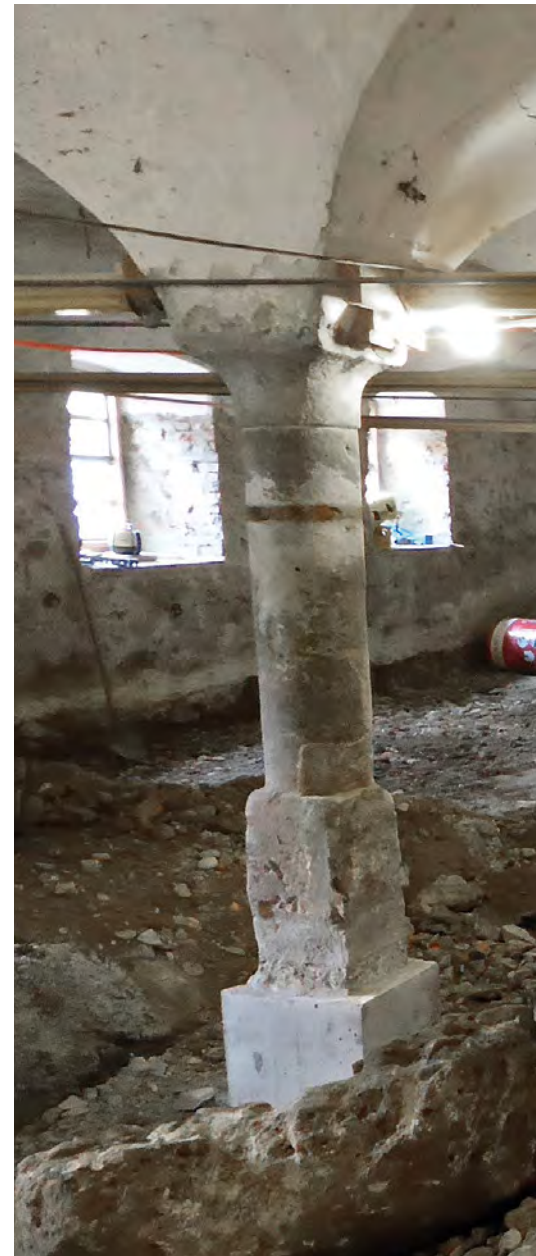
Erste Arbeiten – Abbrucharbeiten im Bereich des neuen Treppenhauses und im Stall (Gewölbe)
