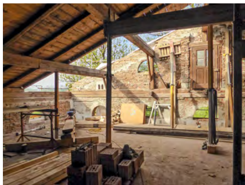
Dachsanierung und Erhalt des historischen Dachstuhls
