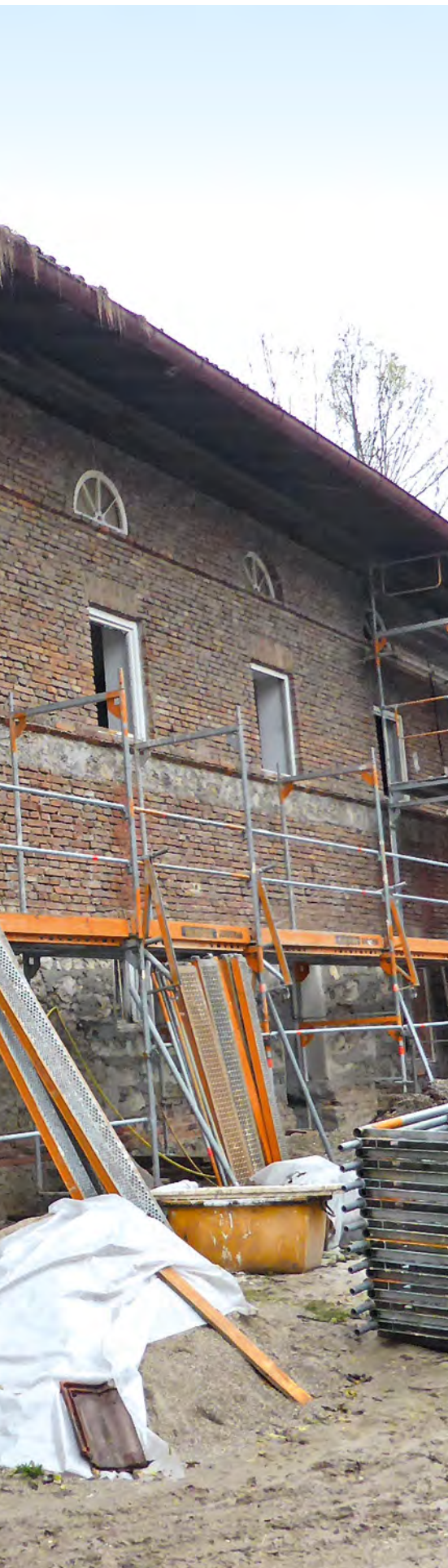
Die Überarbeitung der Fassaden hat begonnen
