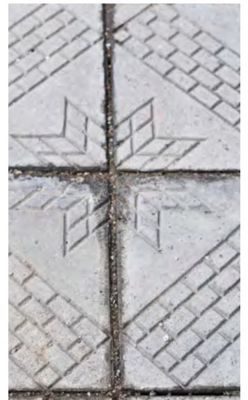
Das alte Pflaster wurde wieder verwendet
