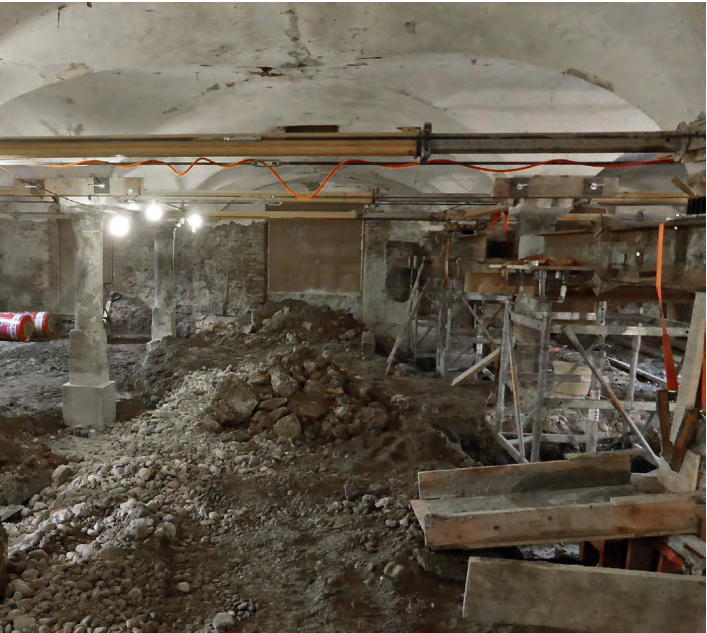
Unterfangung und statische Ertüchtigung der Stützen und Fundamente
