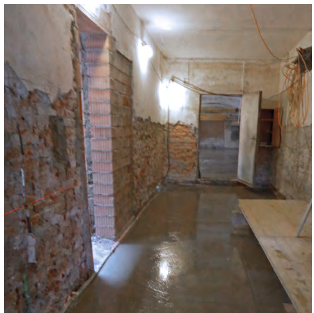
Neue Bodenplatte im Erdgeschoss des Bauernhauses ist eingebaut
