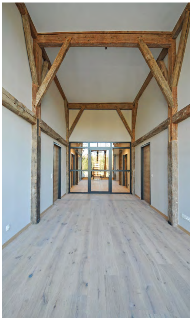
Sichtbare, historische Holzkonstruktion im Tennenbereich
