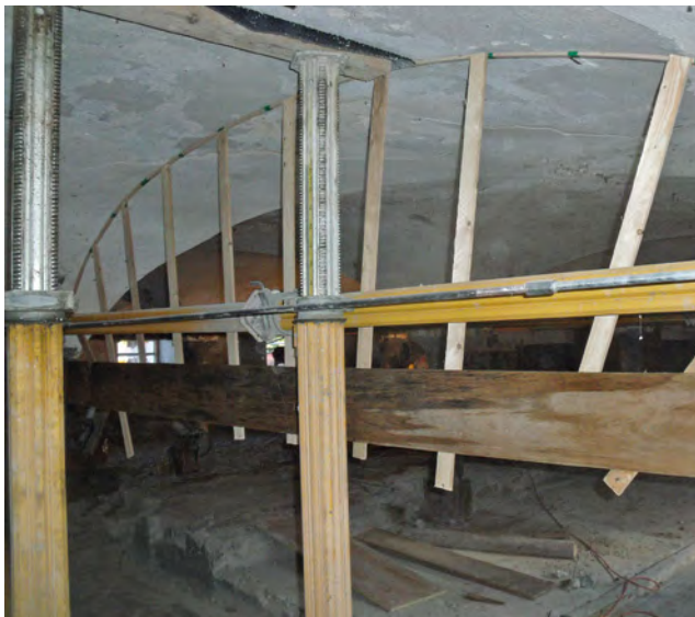
Zahlreiche Abstütz-Maßnahmen waren zur Sicherung des Gebäudes erforderlich
