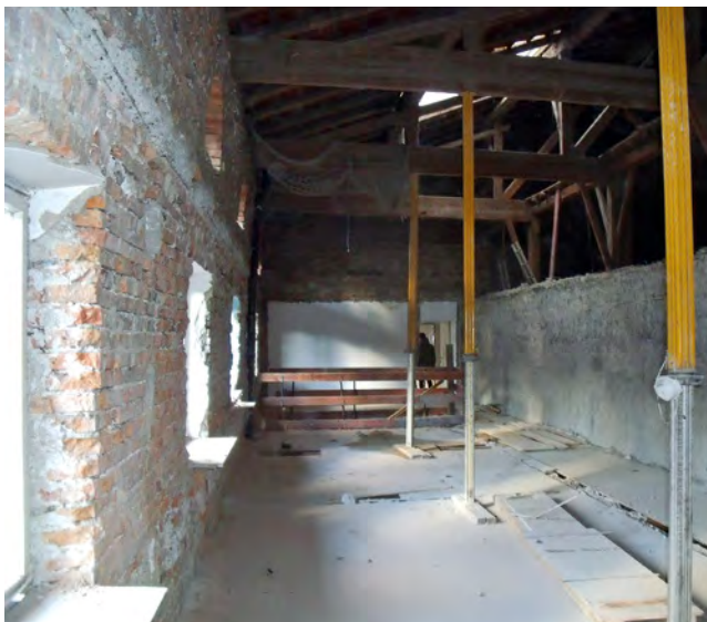
Aussteifung von Decken und des historischen Dachstuhls
